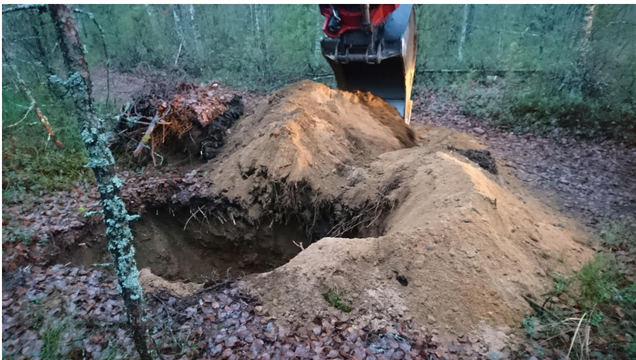
Kuva 2. KK1 sijoitettiin ottokaivantojen ulkopuolelle.
